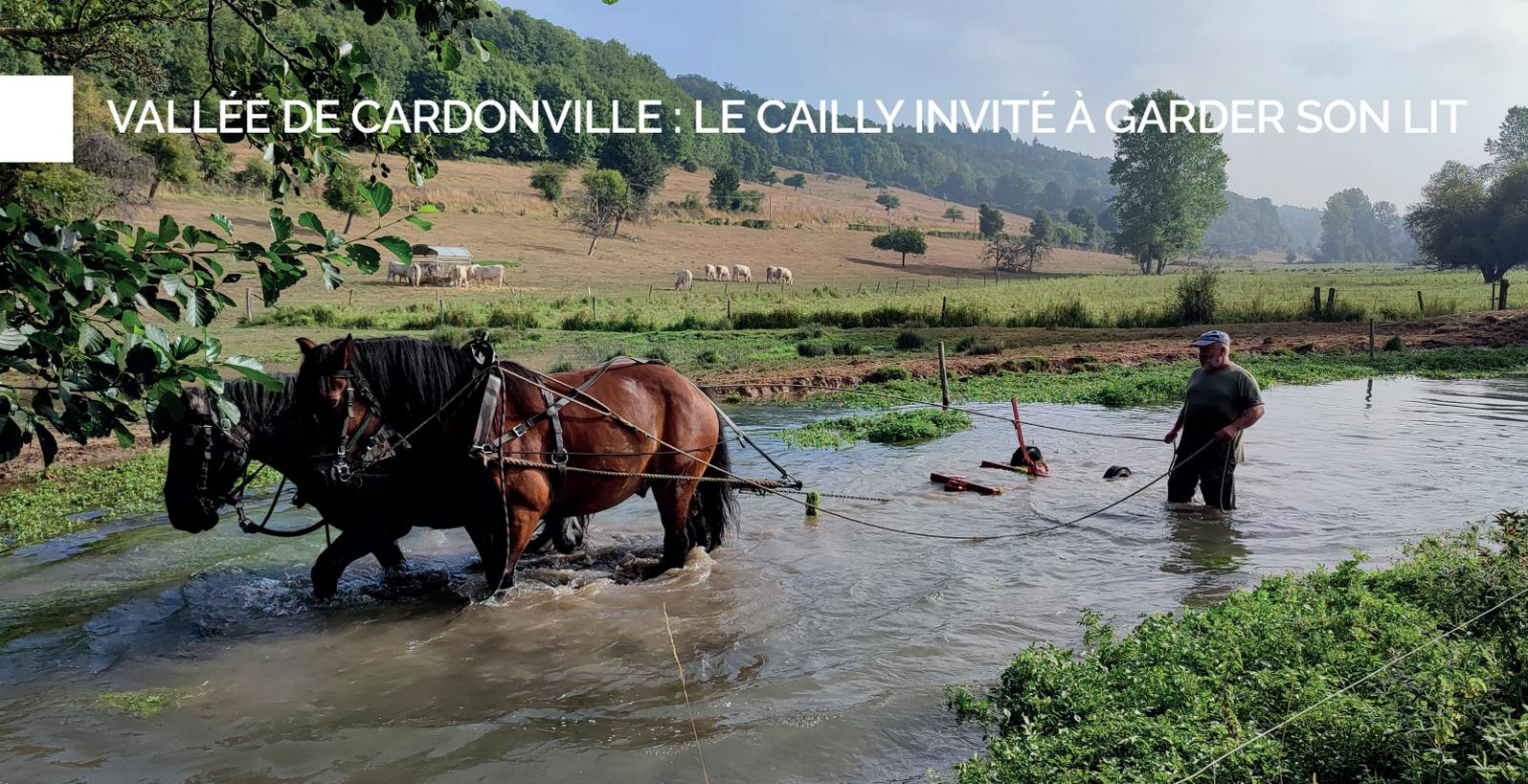
Les engins mécanisés étant interdits en rivière, la casse des concrétions calcaires a été réalisée à l'aide de chevaux par une entreprise spécialisée en travaux par traction animale.
