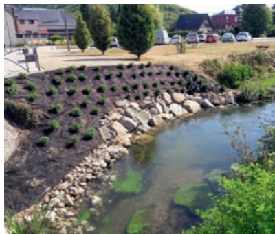
Opération de végétalisation et de renforcement des berges du Cailly
