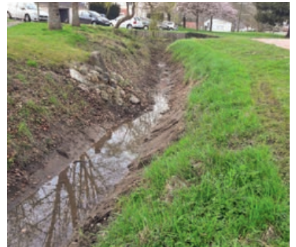
Nettoyage du fossé du quartier du Mont-Blanc
