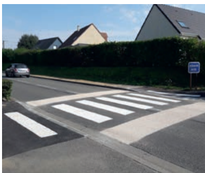
Implantation d'un passage protégé sur la RD 47 à la sortie du Domaine au Sel
