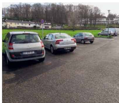
Extension des zones de stationnement de la cité de l'Oyonnithie par l'entreprise MFTP
