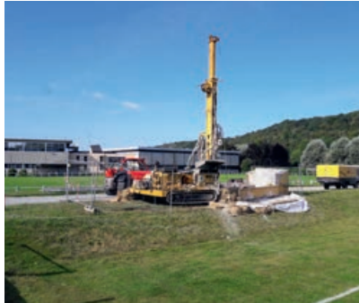
Pose de piézomètres par le SBV
