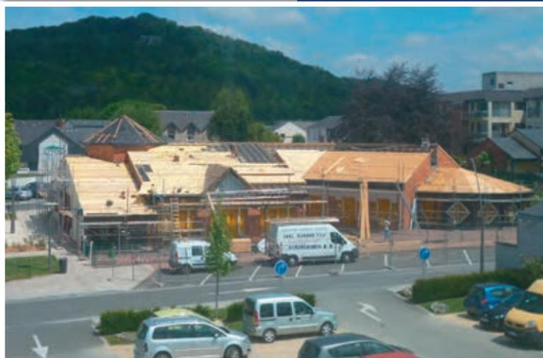
*Parmi les plus importants travaux figure le remplacement de la toiture de l'école maternelle Jeanne-Pincepré. Pendant les vacances d'été, l'entreprise « Durand et Fils » a effectué la pose d'une couverture métallique à joint debout pour un montant de 117 000 €.*
