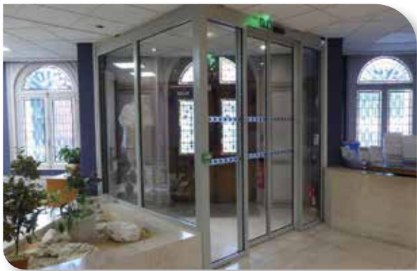
Réalisation d'un nouveau sas d'entrée avec portes automatiques
