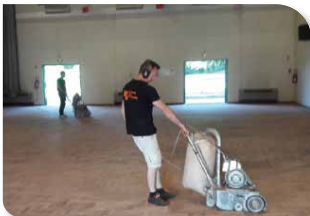
Réfection intégrale du sol "parquet" de l'Espace Jean-Loup Chrétien
