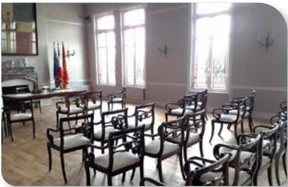
Réfection du sol de la salle des mariages, du palier et des marches dans le hall
