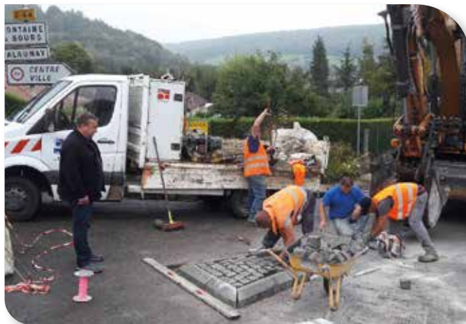
Aménagement d'un carrefour rue de la Gare
