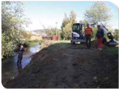
Renaturation des berges
