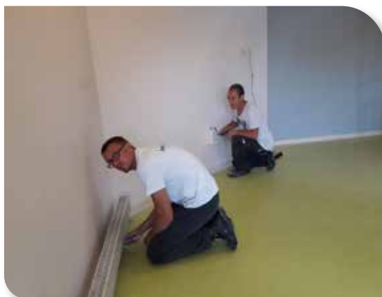
Ecole Pincepré : Réfection complète d'une salle de classe et remise en peinture du tracé des jeux extérieurs
