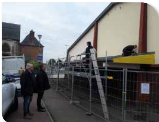
Remplacement et mise en lumière de la casquette salle Lebarbier
